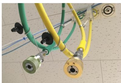
緑色のガスホース(酸素)と黄色のガスホース(空気)を壁配管にしっかりと押し込み接続する。
